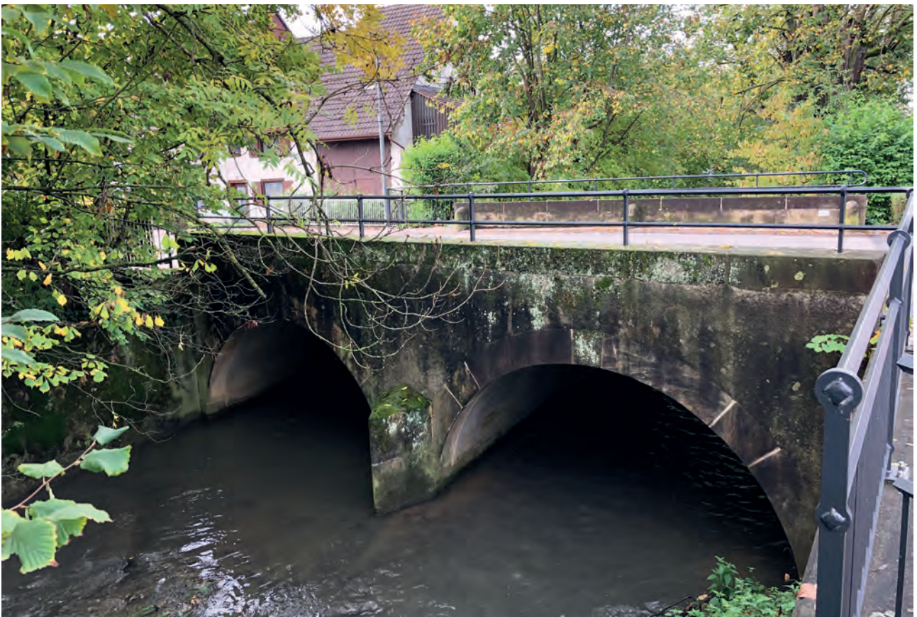
Bild 2: Brücke, Sicht von Osten
