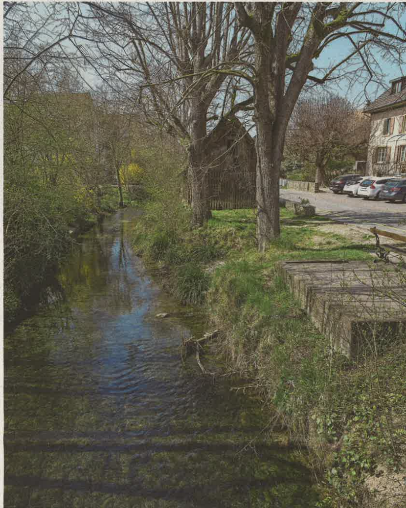
Der Birsig soll in Biel-Benken beidseits Mauern erhalten.
