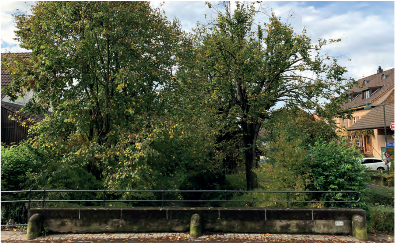
Bild 1: Blick von der Brücke nach Westen
