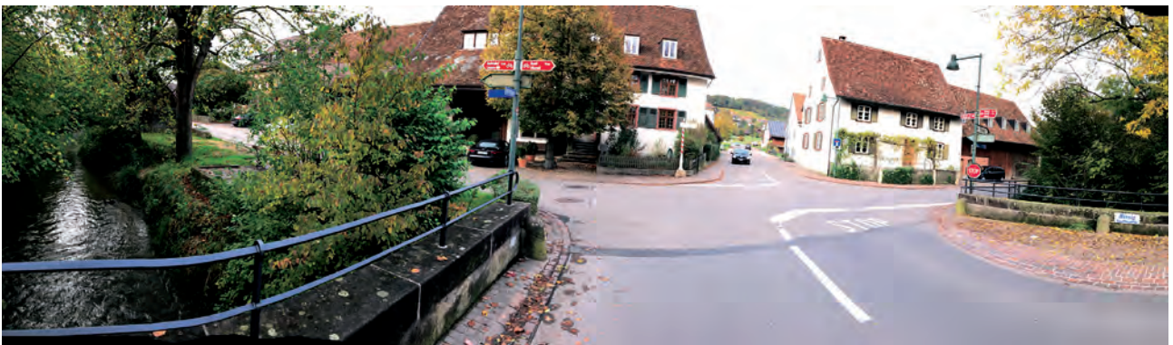
Bild 5: Panorama der Brücke nach Norden
