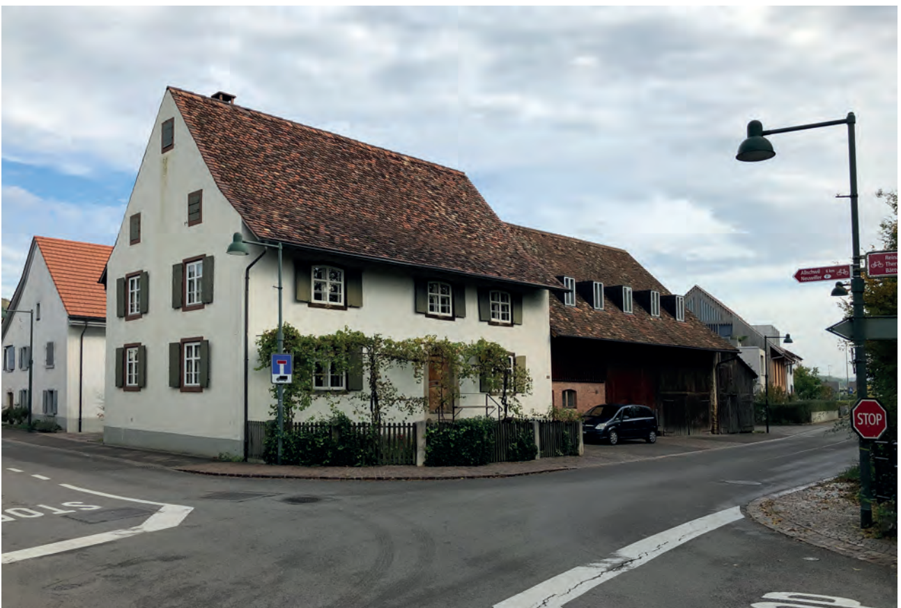
Bild 11: Blick von der Brücke auf das kantonal zu schützende Haus Fraumattenstrasse 1. Das neue Strassenniveau tangiert den Vorgarten.
